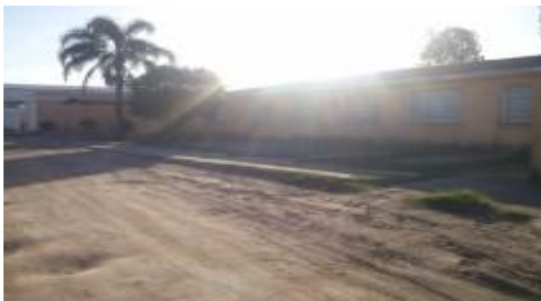
Foto 1 - Prédio da Escola Especial José Luiz Piúma/ APAE Jaguarão Fonte: Fotos feitas pela autora
