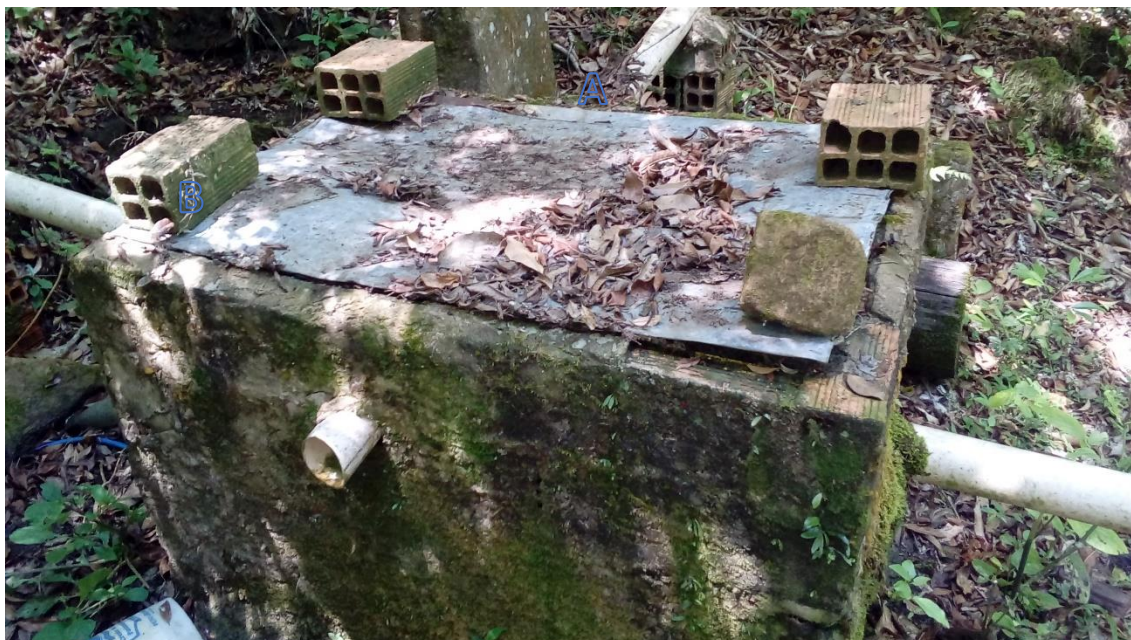
Figura 26 – Caixa d'água de tijolos e cimentos tampada, cuja qual recebe a água das nascentes A (amostra 3) e B (amostra 4).
