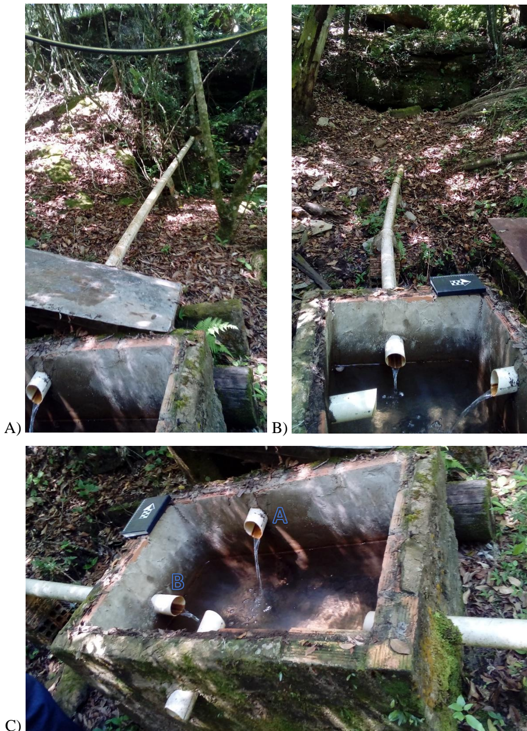
Figura 27 – Mesma caixa da imagem anterior, porém agora descoberta. A) Indica o local da nascente d'água A, da qual foi coletada a amostra 3. B) Indica o local da nascente B, de onde foi coletada a amostra 4. C) Caixa mostrando as duas entradas de água e duas saídas, onde, no sentido horário partindo do cano superior: entrada de água da nascente A; saída para caixa d'água de plástico; ladrão; e entrada de água da nascente B.
