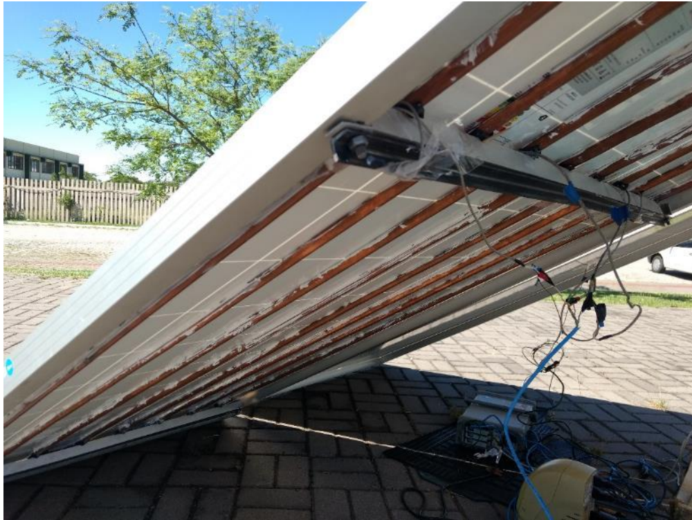
Figura 16 - Serpentina de cobre instalada no módulo fotovoltaico com arrefecimento.
