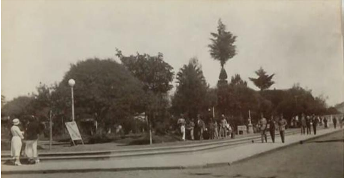
Figura 8 - Degraus construídos em 1972
