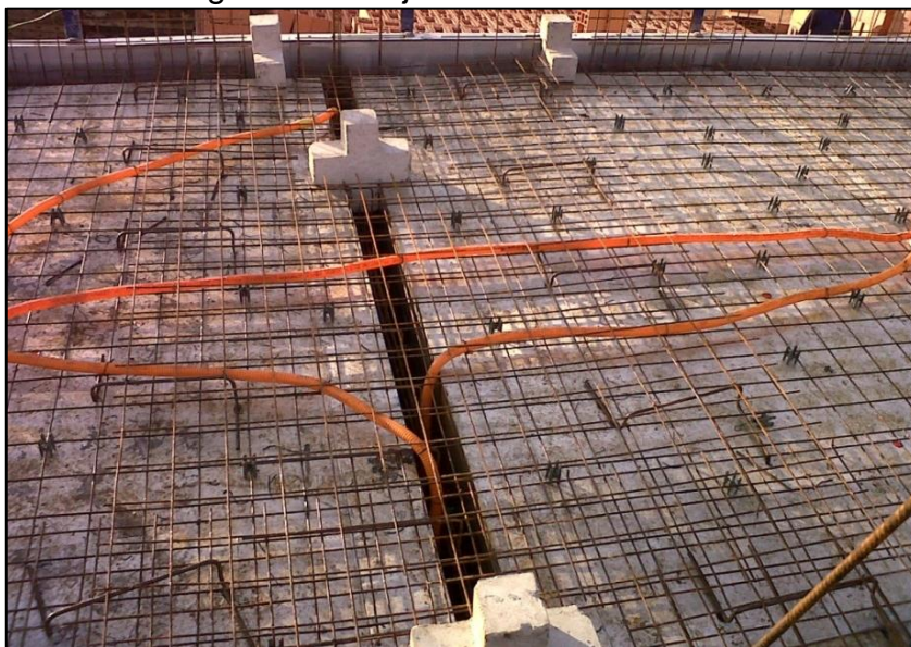
Figura 11 – Lajes armadas com telas
