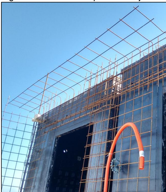
Figura 15 – Armadura parede x laje em L
