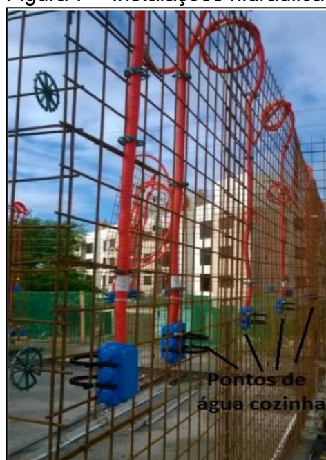
Figura 7 – Instalações hidráulicas
