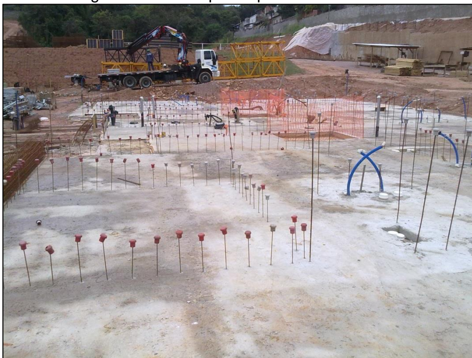
Figura 18 – Arranque de parede com adesivo
