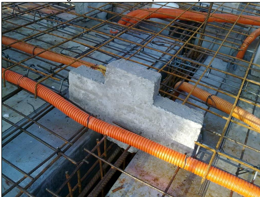
Figura 14 – Armadura parede x laje
