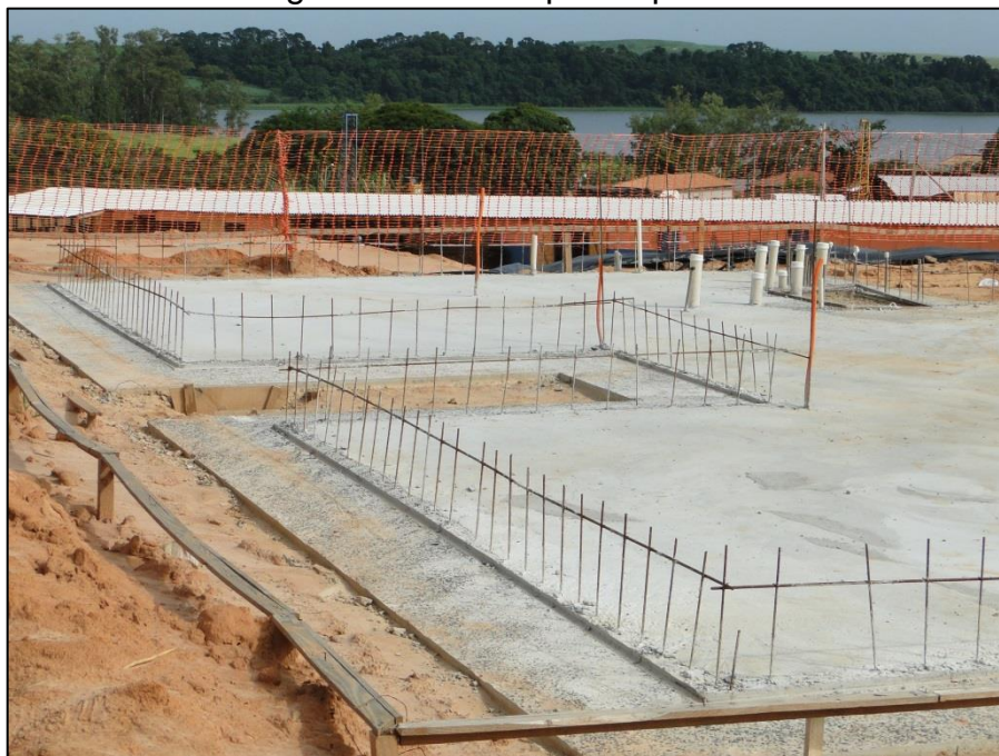
Figura 17 – Arranque de parede
