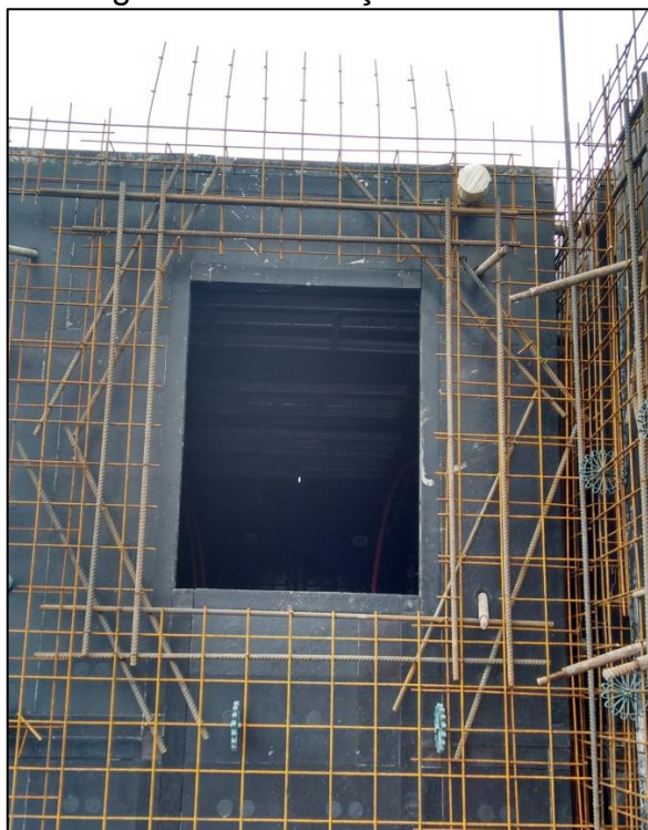
Figura 19 – Reforço de abertura
