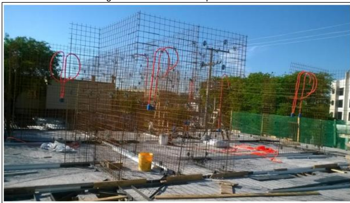
Figura 10 – Tela soldada posicionada
