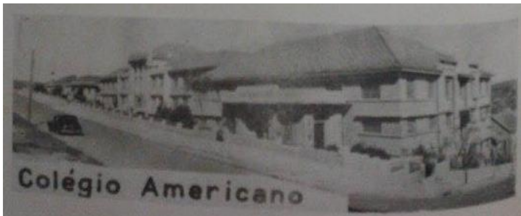
Figura 7 - Prédio Henry Pfeiffer do Colégio Americano (ao centro).
