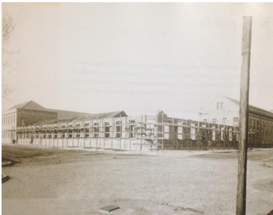
Figura 3 -Obras para construção do novo liceu
