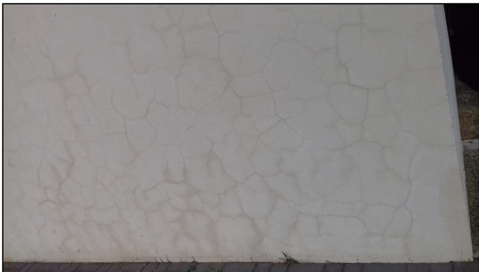
Figura 29 - Fissuras mapeadas
