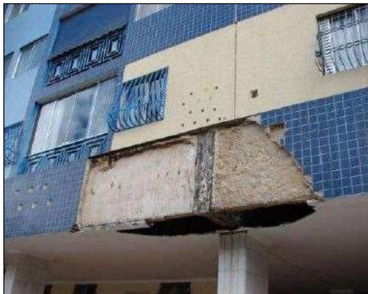
Figura 9 - Desplacimento
