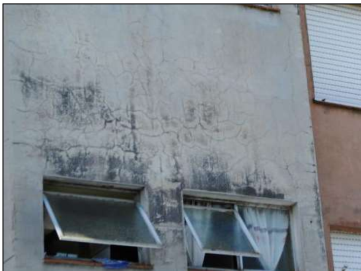
Figura 7 - Fissuras mapeadas
