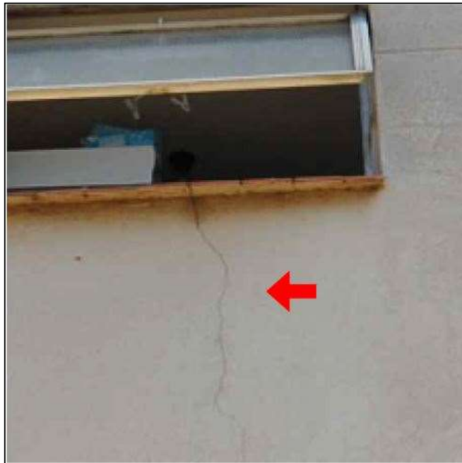
Figura 6 - Fissuras Verticais
