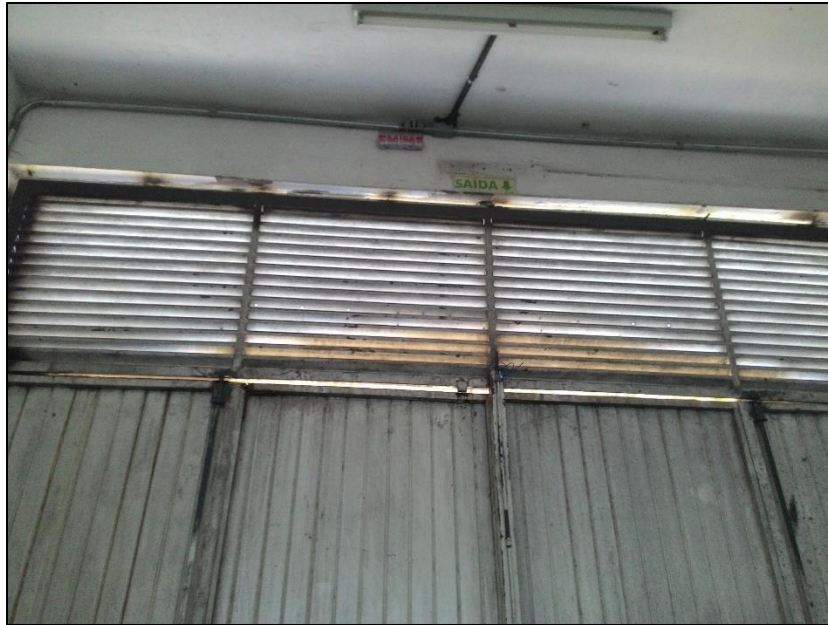
Figura 74 - Sinalização descarga / Bloco 2
