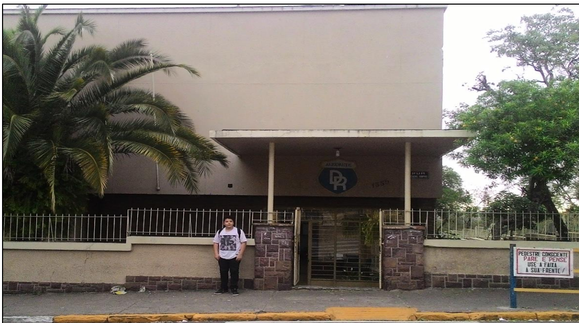
Figura 45 – Vista Frontal da Escola B
