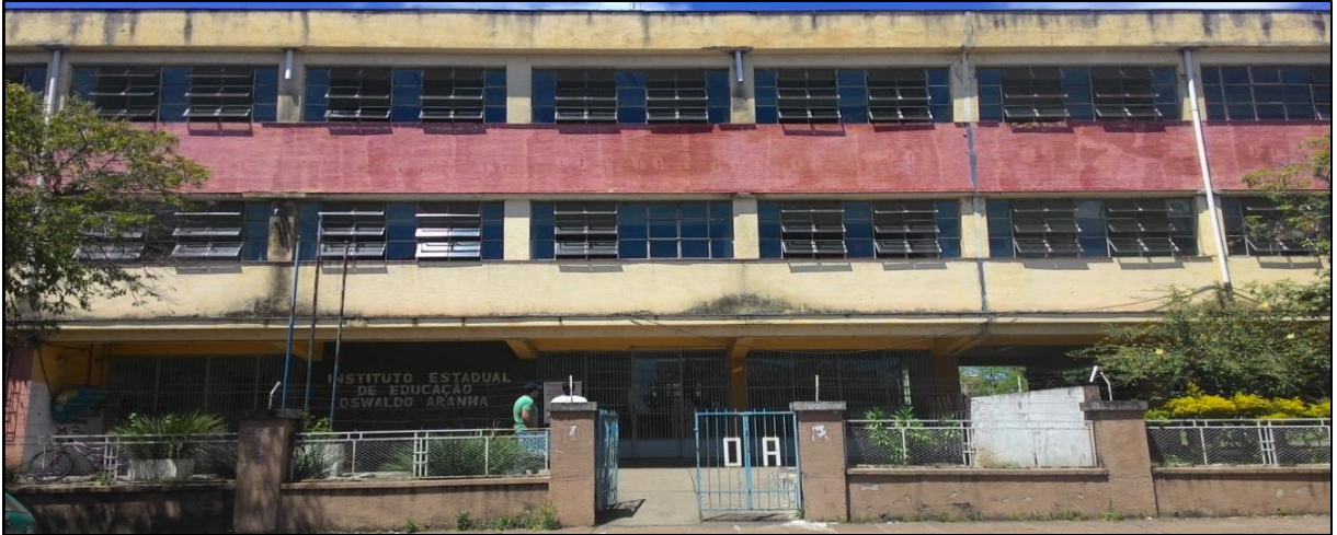
Figura 67 – Vista de Frente da Escola E, Bloco 1
