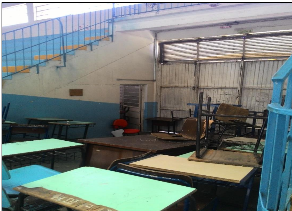
Figura 71 - Bloqueio de descarga / Bloco 2
