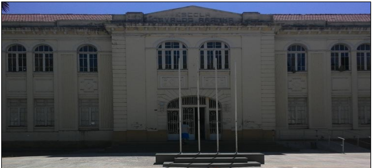
Figura 68– Vista de Frente da Escola E, Bloco 3.
