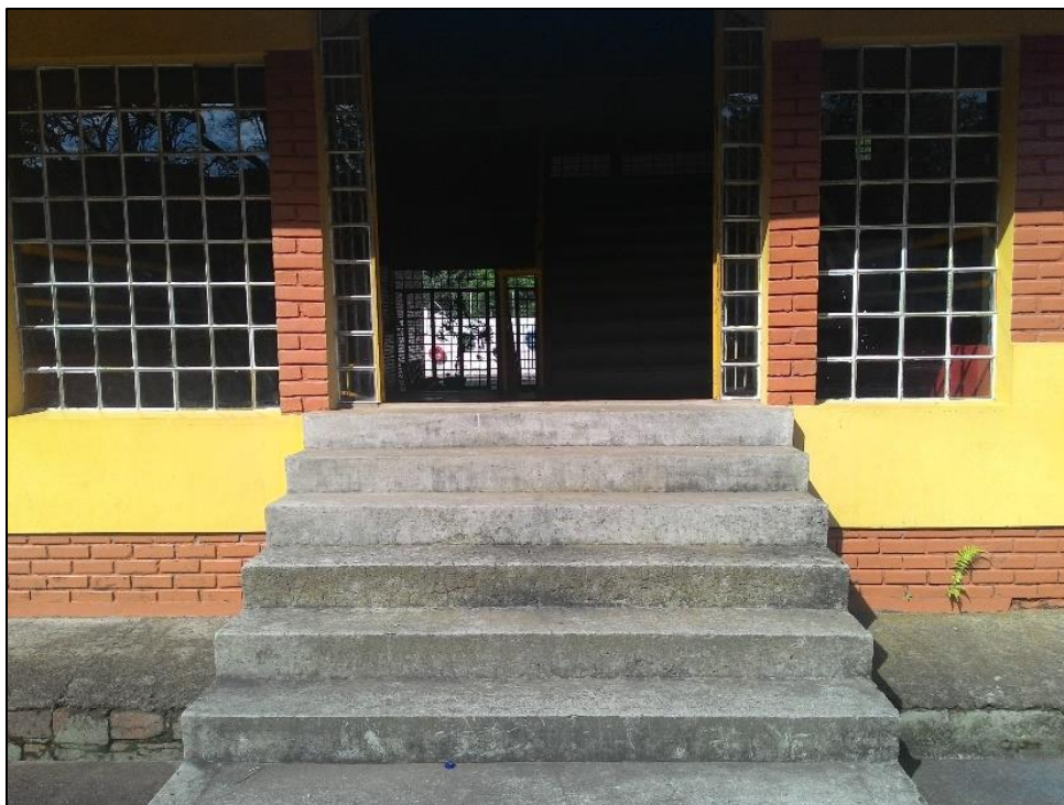
Figura 55 - Escada do patamar / Bloco 1
