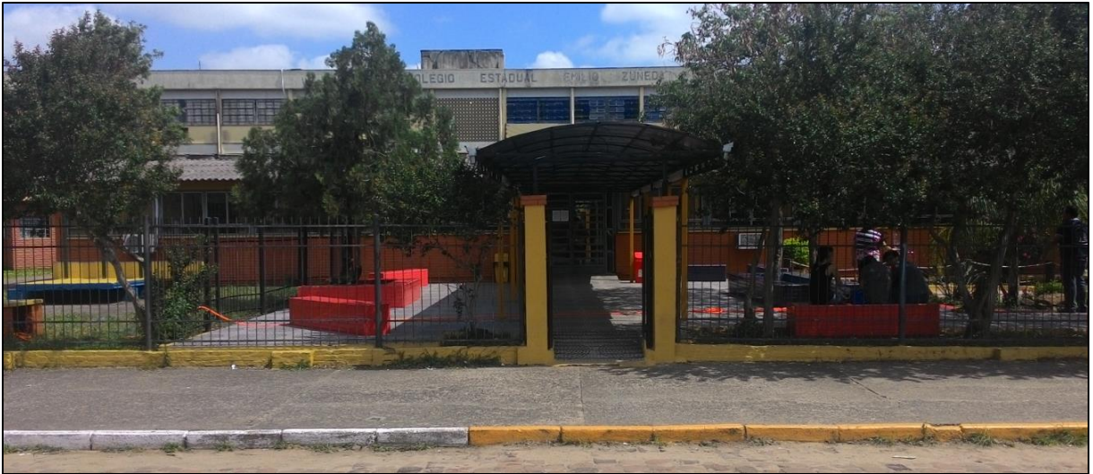
Figura 58 – Vista de Frente da Escola D
