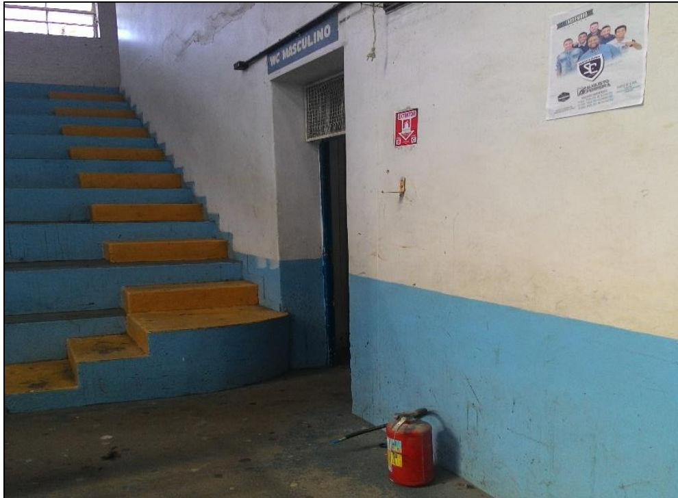
Figura 70 - Degraus das arquibancadas / Bloco 2
