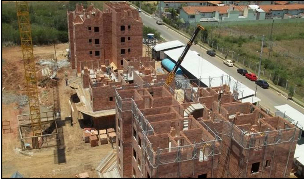
Figura 1- Sistema construtivo em alvenaria estrutural
