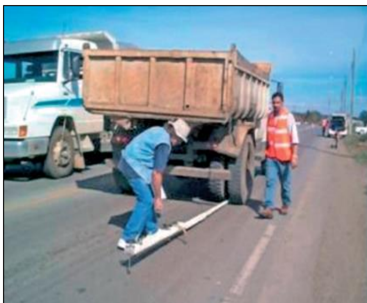
Figura 4 – Medida com viga Benkelman em campo
