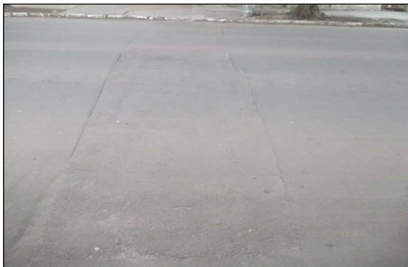
Figura 64 – Remendos de manutenção da drenagem na Rua Bento Manoel
