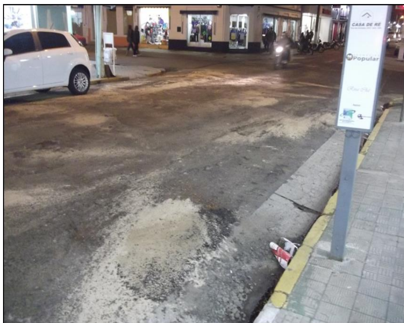
Figura 41 – Aspecto da Rua dos Andradas no período da noite pós-manutenção
