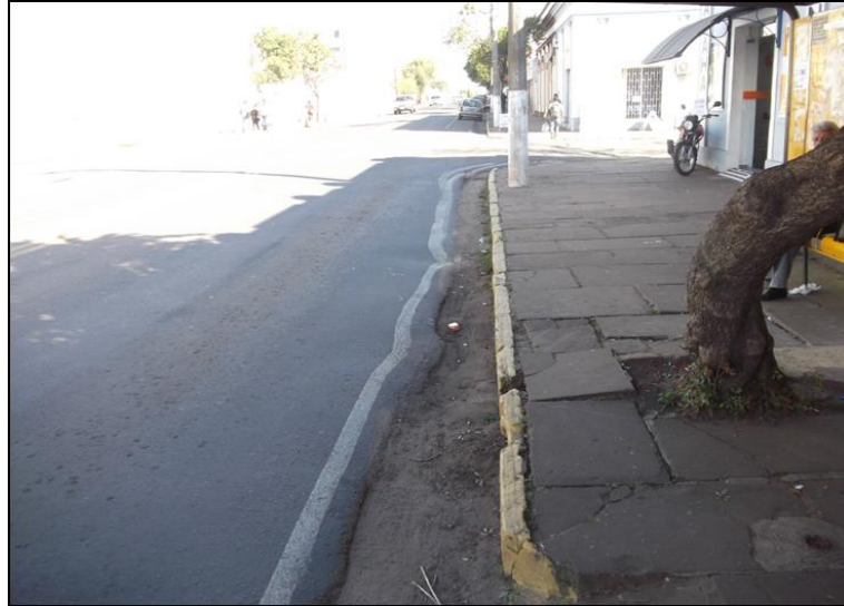
Figura 26 – Afundamento local na Av. Assis Brasil
