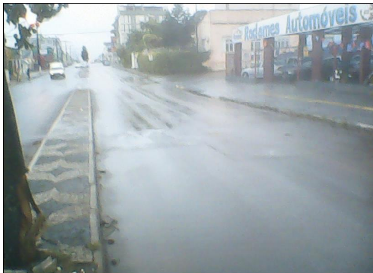
Figura 37 – Formação de lâminas d'água na pista da Av. Dr. Lauro Dornelles
