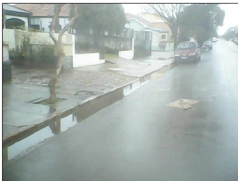
Figura 67 – Acúmulo de água em pontos entre pista/acostamento
