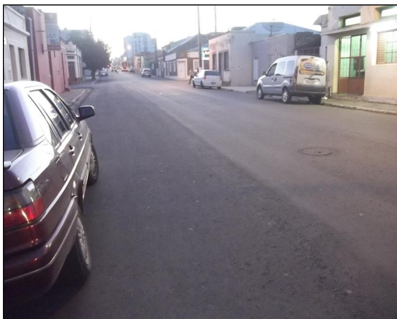
Figura 55 – Recalque Diferencial verificado na Rua Barão do Amazonas
