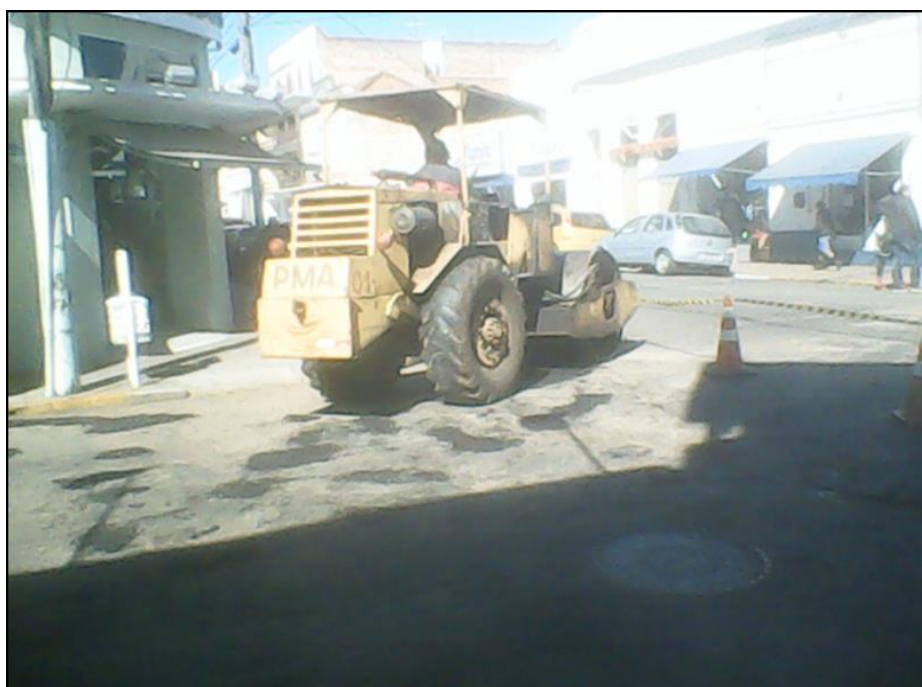
Figura 39 – Operação tapa-buraco realizada na Rua dos Andradas
