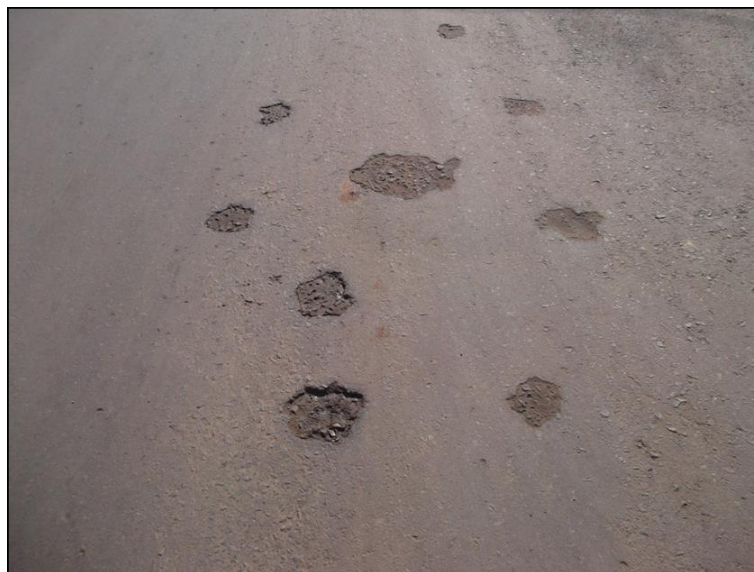
Figura 25 – Panelas encontradas na Av. Assis Brasil
