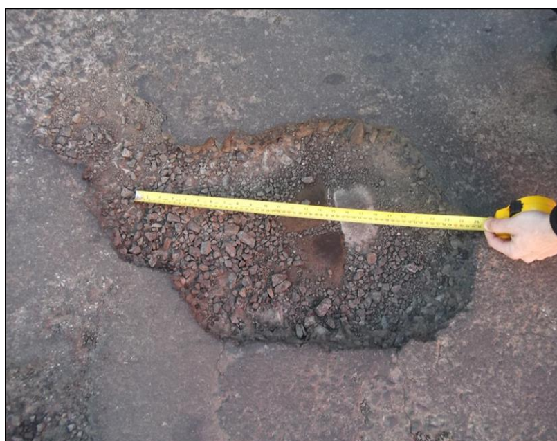
Figura 44 – Panela encontrada na Rua dos Andradas
