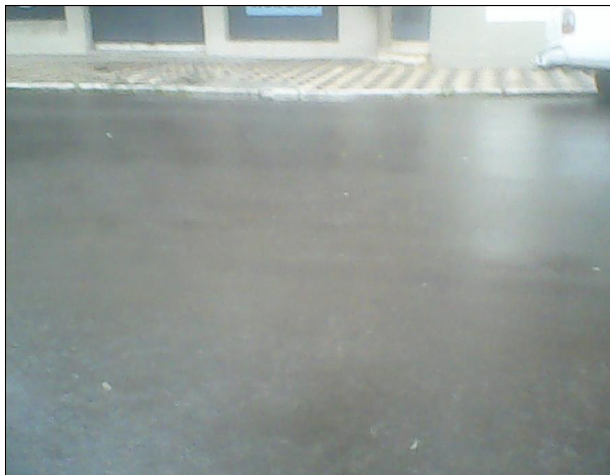
Figura 57 – Aspecto da Rua Barão do Amazonas em um dia chuvoso
