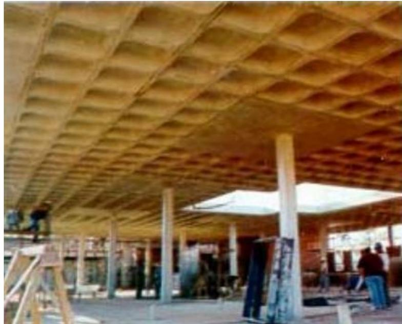
Figura 3: Representação de uma estrutura com laje nervurada lisa com capitéis.
