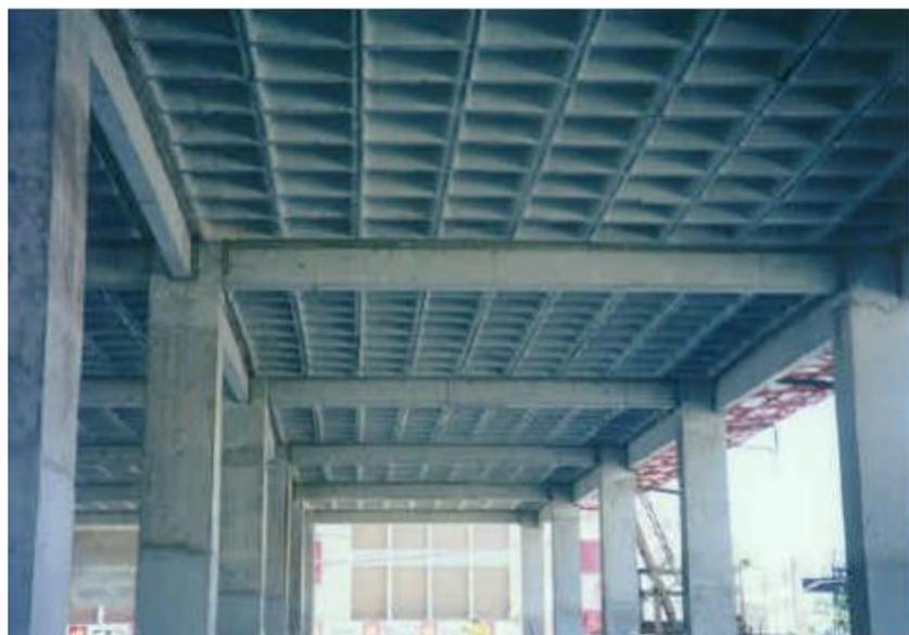
**Figura 2: Representação de uma estrutura com laje nervurada.**
