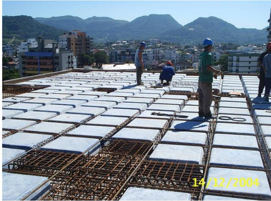
**Figura 4: Representação de uma estrutura com laje nervurada que utiliza fôrmas de polipropileno.**
