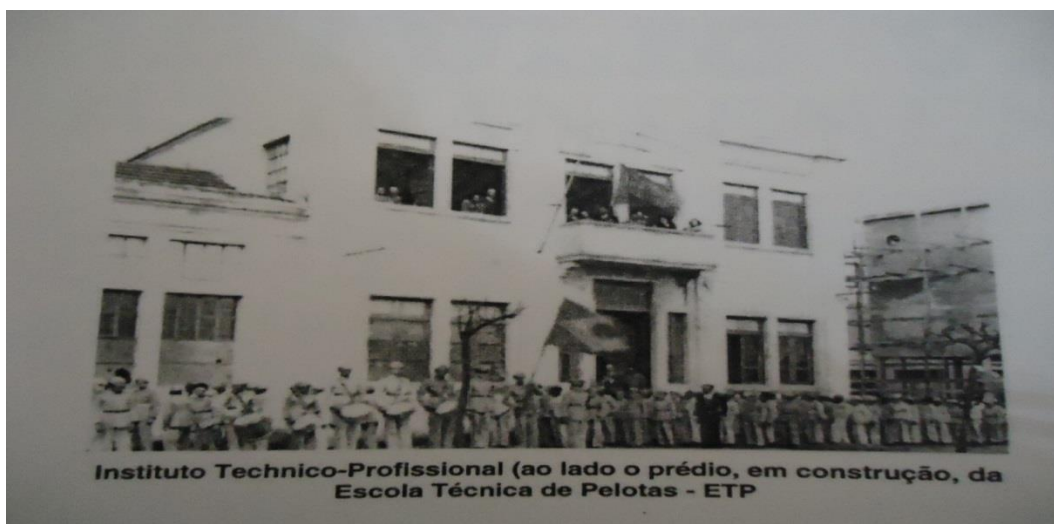
Figura 1: Foto do Instituto Technico-Profissional (ao lado o prédio em construção, da ETP)
