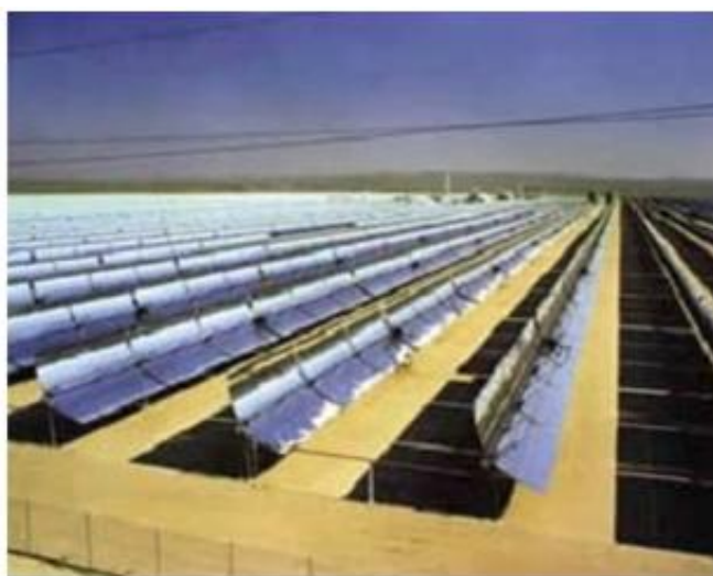
Figura 8 Sistema térmico solar de geração de energia elétrica
