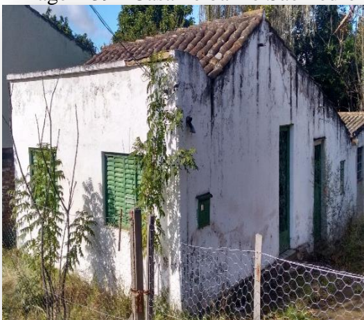
Imagem 39 - Casa no bairro São Pedro
