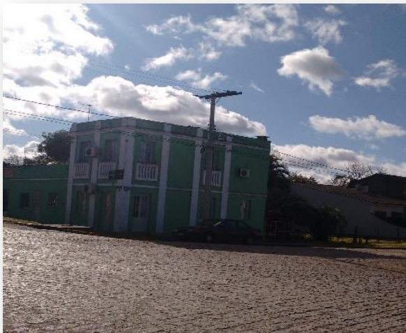
Imagem 41 - Sobrado próximo à rodoviária
