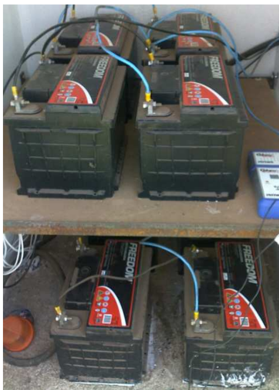
Figura 10 – Banco de Bateria
