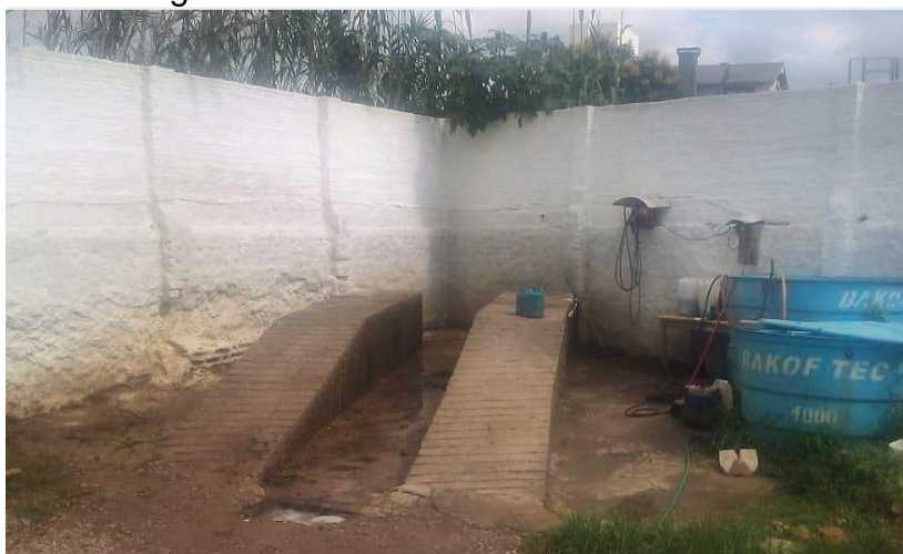
Figura 7 – Local de lavagem de veículos
