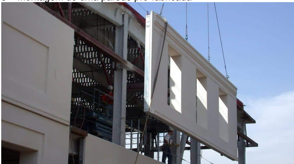
Figura 16 – Montagem de uma parede pré-fabricada
