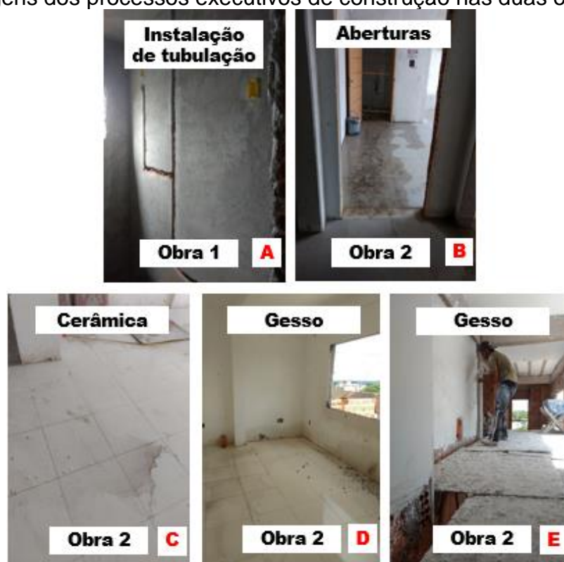
Figura 22 – Imagens dos processos executivos de construção nas duas obras
