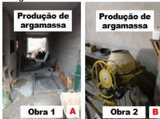
Figura 20 – Produção de argamassa nos dois canteiros de obras
