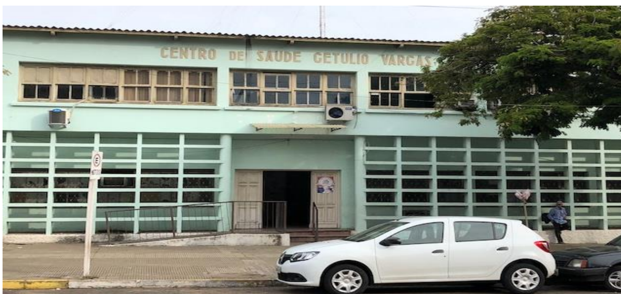
FIGURA 1- Fachada do prédio da Vigilância Ambiental em Saúde (VAS) do município de Uruguaiiana. Fonte: Vigilância Ambiental em Saúde.
