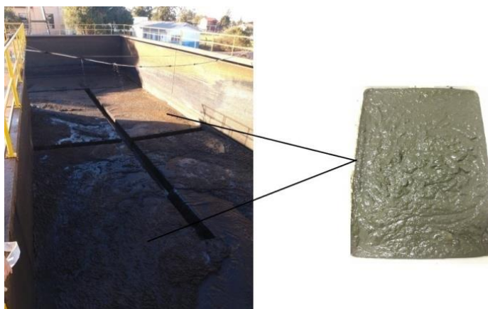
Figura 6 - Tanque de sedimentação e lodo bruto coletado.
