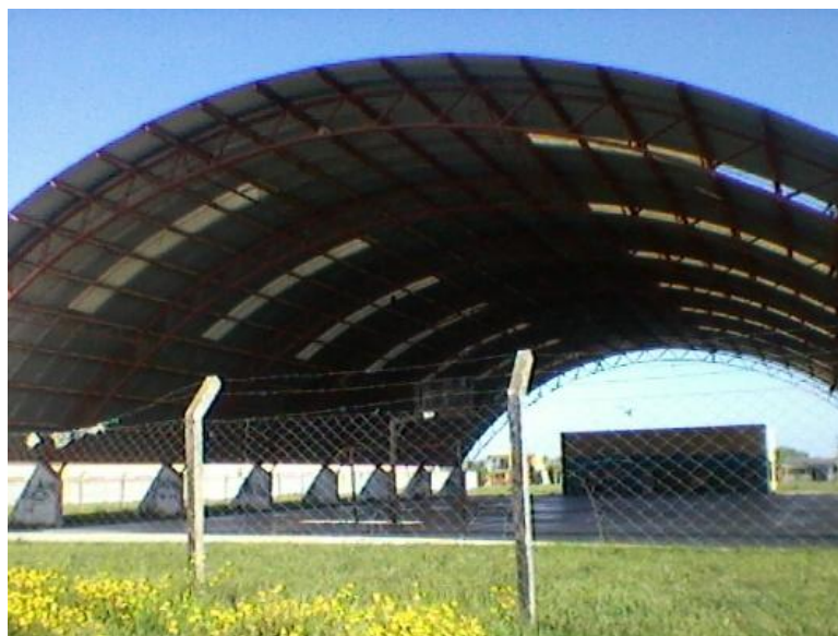
Figura 2 – Foto da quadra coberta ao lado da Escola Municipal Santa Irene
