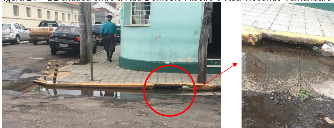
Figura 21 – BL situada entre a Rua Demétrio Ribeiro e Rua Visconde Tamandaré
