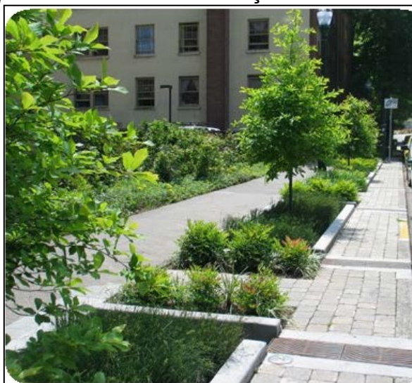
Figura 5 – Stormwater planters utilizadas em calçadas na área urbana
