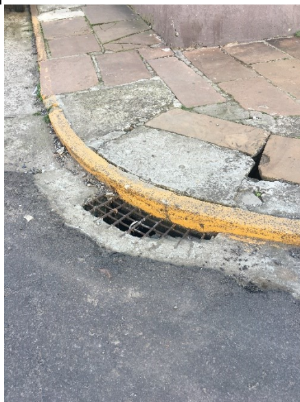
Figura 22 – BL grelha, esquina Rua Demétrio Ribeiro com Rua Tiradentes
