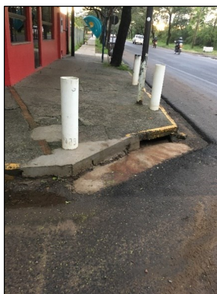
Figura 19 – BL de guia situada na esquina da Avenida Alexandre Lisboa com Parque Rui Ramos
