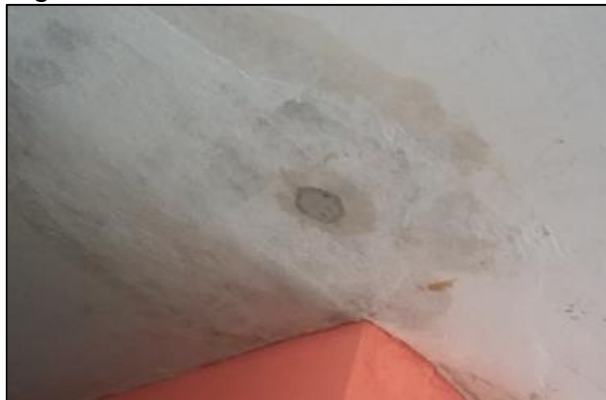
Figura 6 - Mancha no teto
