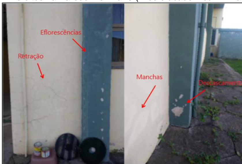
Figura 47 - Defeitos na Parede 2 e Pilar 3 (Prédio acadêmico 2 – Fachada Sul)
