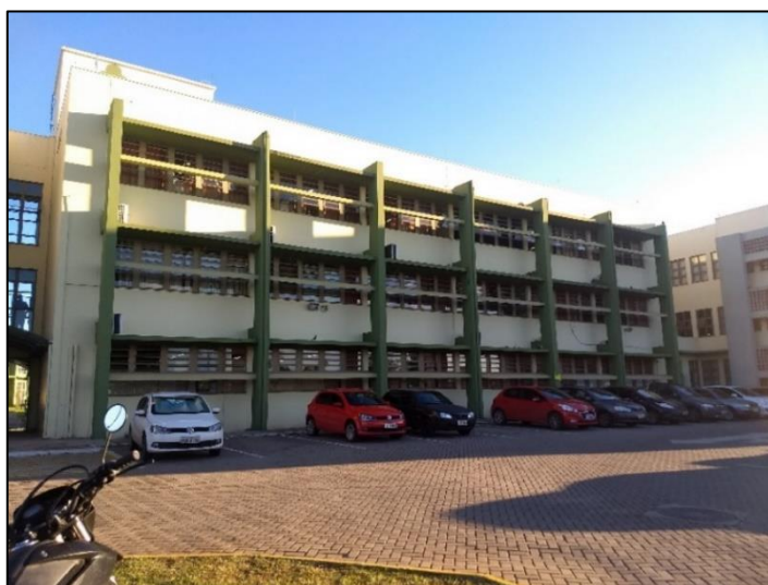
Figura 27 - Prédio Acadêmico 1 (Fachada Norte)
