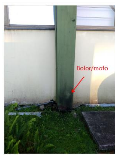
Figura 35 - Defeitos no Pilar 3 (Prédio acadêmico 1 – Fachada Sul)
