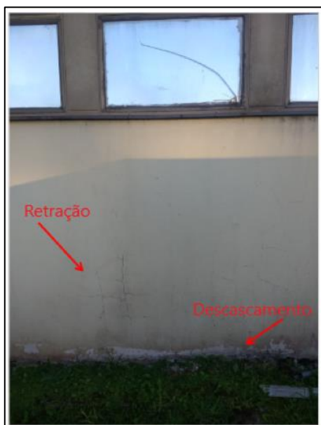
Figura 36 - Defeitos na Parede 3 (Prédio acadêmico 1 – Fachada Sul)
