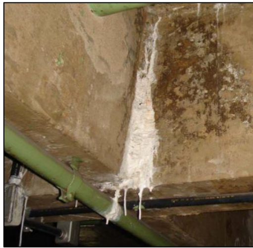
Figura 7 - Eflorescência em encontro de vigas
