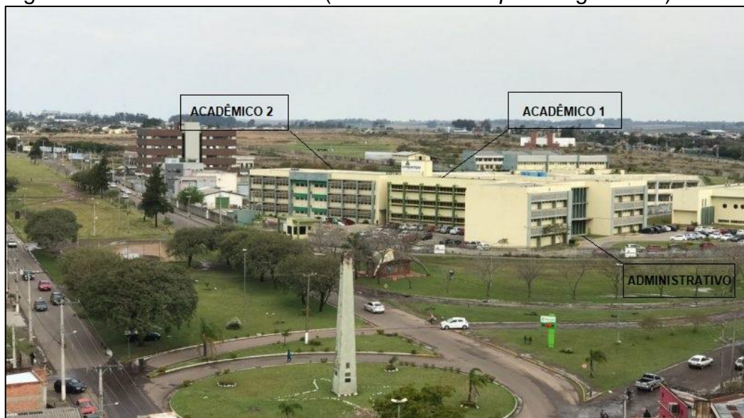
Figura 24 – Prédios analisados (UNIPAMPA campus Alegrete/RS)
