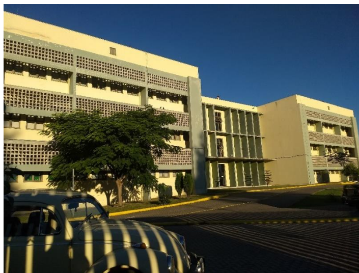
Figura 55 - Prédio Administrativo (fachada oeste)
