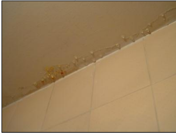
Figura 5 - Infiltração na laje
