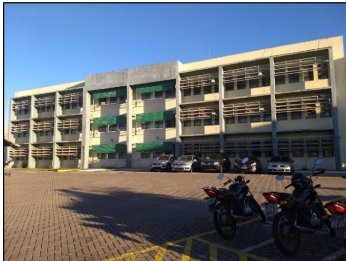
Figura 40 - Prédio Acadêmico 2 (Fachada Norte)
