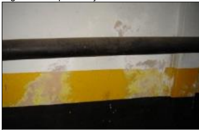
Figura 9 - Saponificação no Reboco
