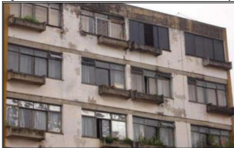
Figura 11 - Bolor ou mofo na fachada de uma edificação
