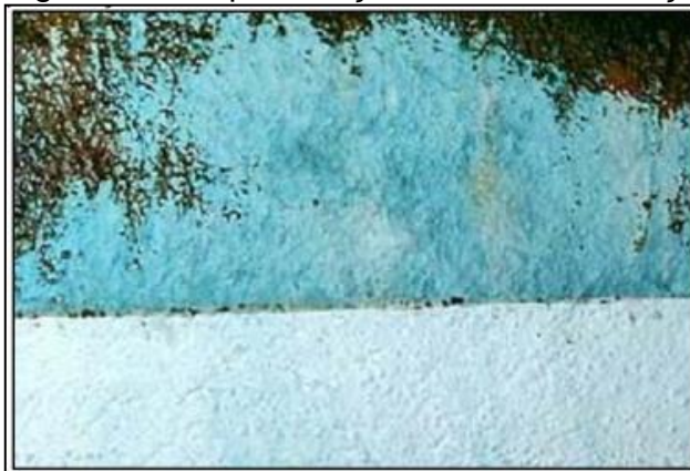
Figura 10 - Saponificação em uma Edificação
