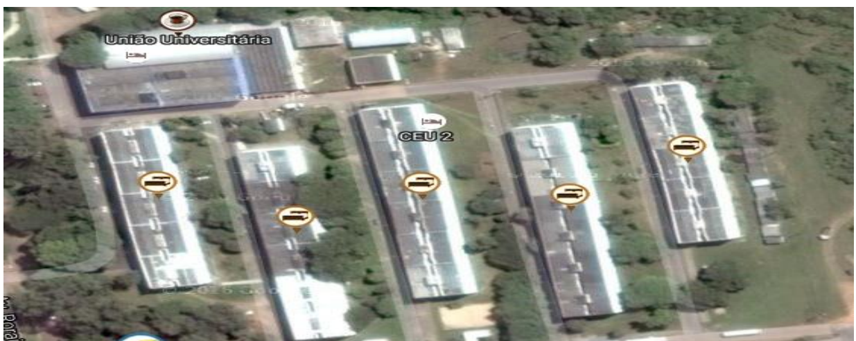
Figura 2 - Prédio da União Universitária e da Casa de Estudantes II
