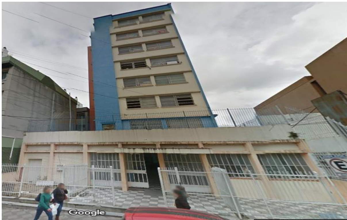
Figura 3 - Prédio da Casa de Estudantes – Centro de Santa Maria
