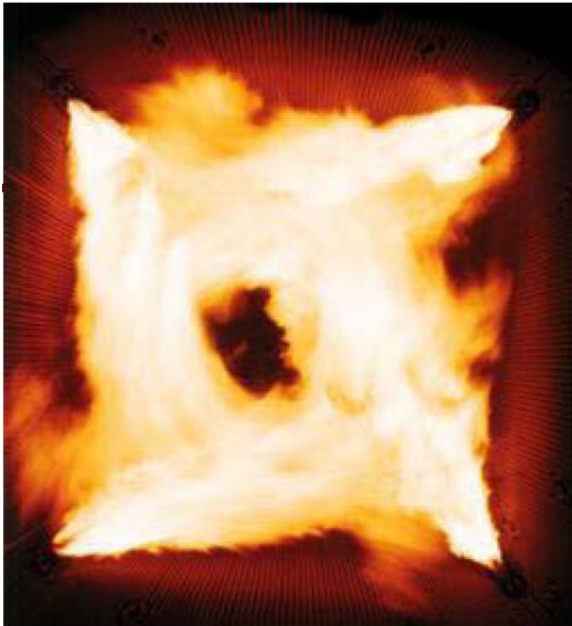
Figura 9 - Imagem da câmara de combustão de uma caldeira em funcionamento.
