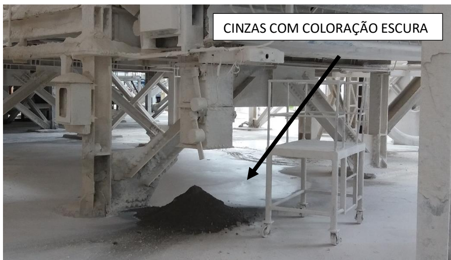
Figura 29 - Ponto de coleta de cinza leve proveniente da fornalha, indicando cinzas com coloração escura, com alto teor de carvão incombusto.
