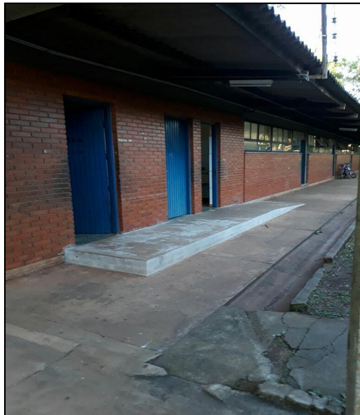
Figura 5 – Entrada dos banheiros
