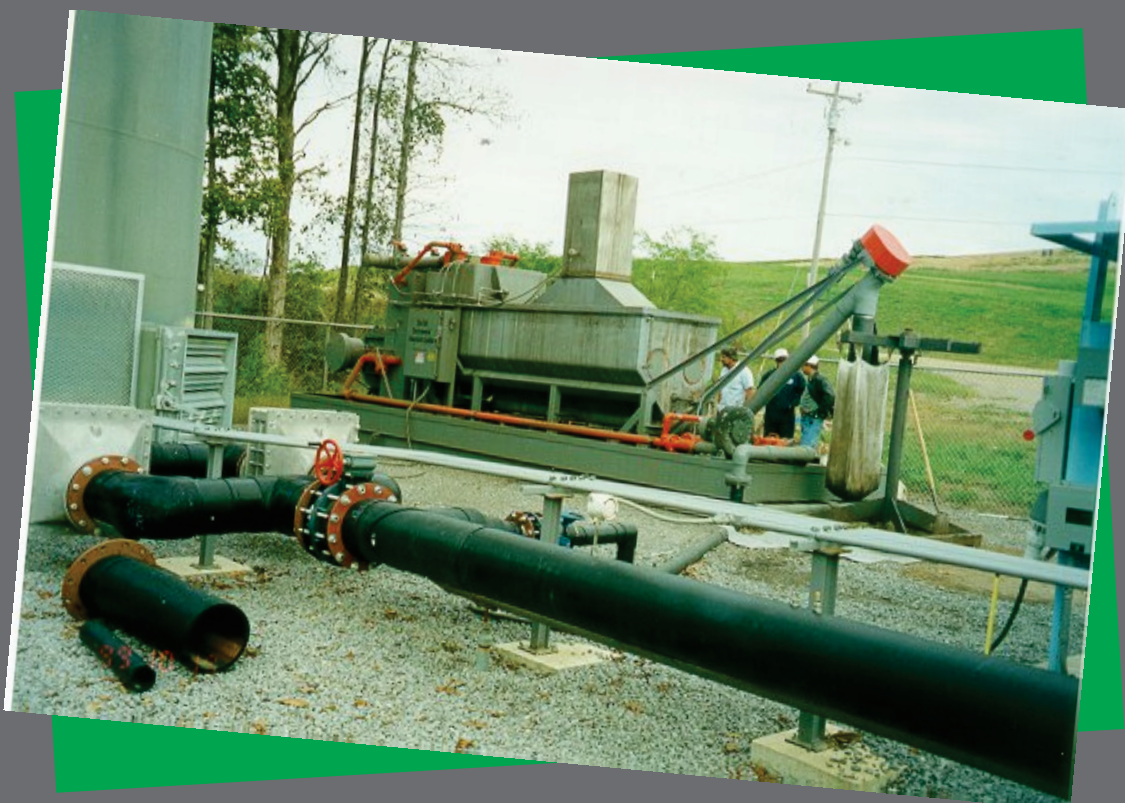
Tubulação retira o biogás do aterro
