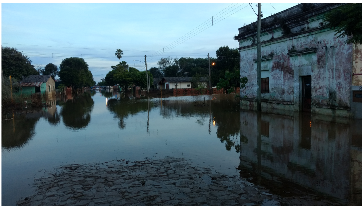
Figura 39 – Registro fotográfico da inundação no dia 15/06/2017 Ponto 6
