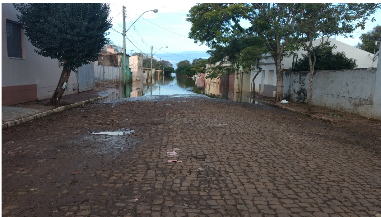
Figura 37 – Registro fotográfico da inundação no dia 15/06/2017 Ponto 4
