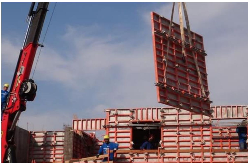
Figura 19 – Montagem das fôrmas
