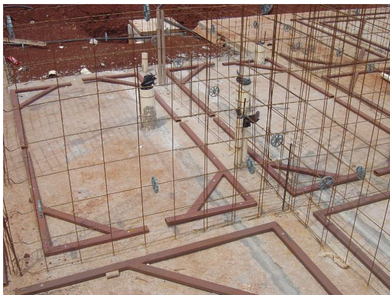
Figura 17 – Marcação e armação das paredes
