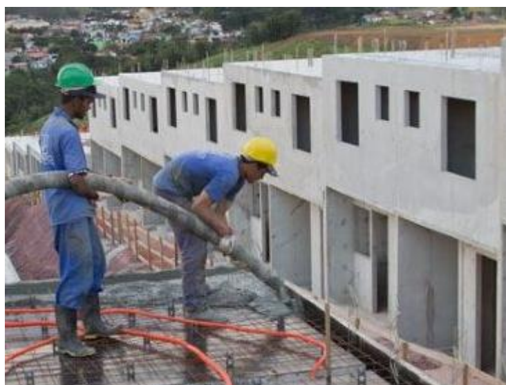
Figura 20 – Concretagem
