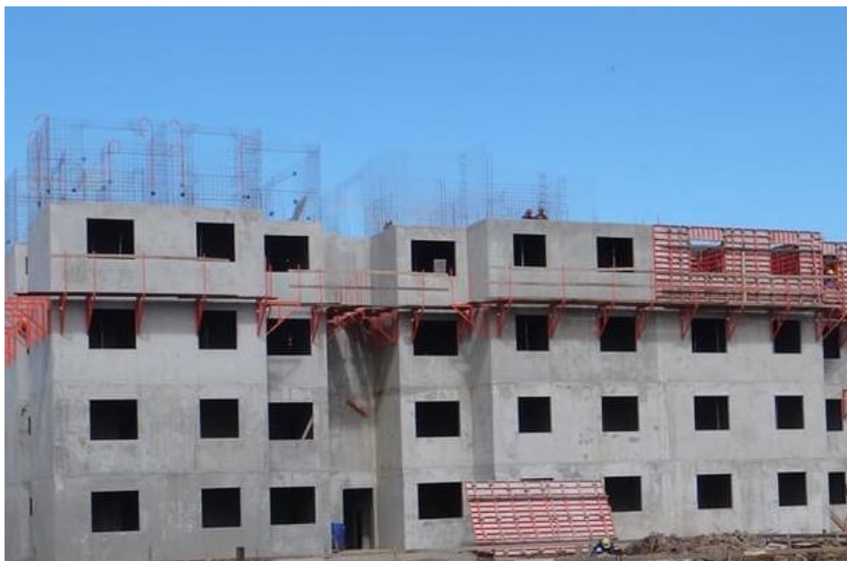
Figura 21 – Desforma das paredes
