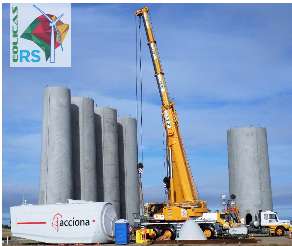
Figura 12 – AW125/3000 sendo instalado no Parque Eólico Mangueira e Mirim em Santa Vitoria do Palmar - RS.
