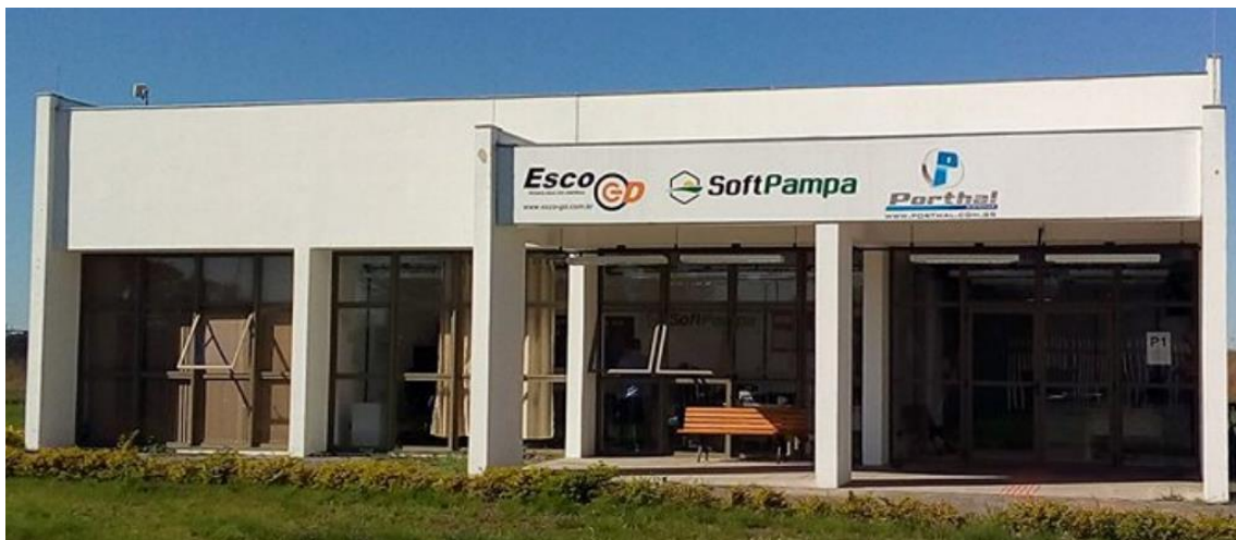
Figura 15 – Fachada do Prédio Esquerdo.
