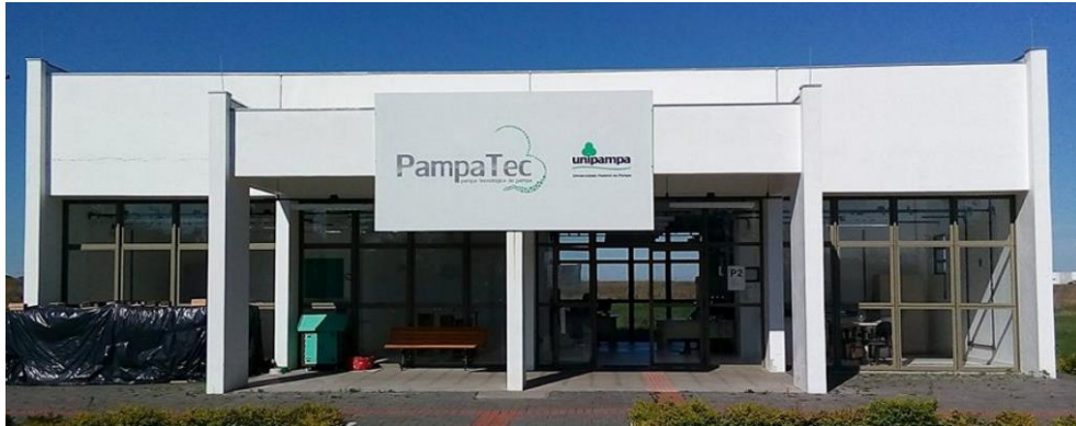
Figura 12 – Fachada do Prédio Administrativo.
