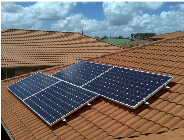
Figura 9 – Exemplo de um Painel Fotovoltaico.
