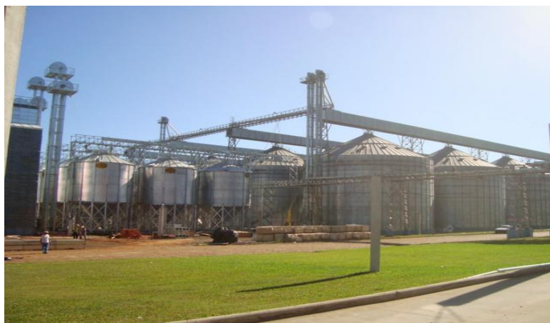
Figura 2 – Ampliação da unidade de recebimento de grãos. [Fonte: Do autor, 2013]
