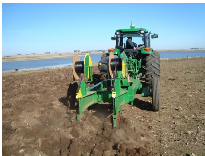
Figura 19 – Instalação das tubulações
