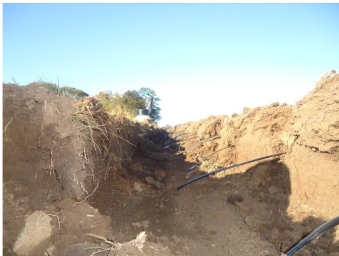
Figura 20 – Valas para instalação das tubulações
