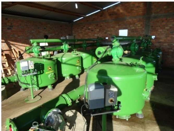
Figura 18 – Estação de Filtragem
