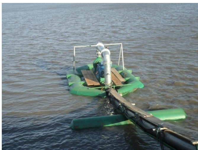
Figura 17 – Bomba de 7,5 cv, 45m 3 /h e 44mca
