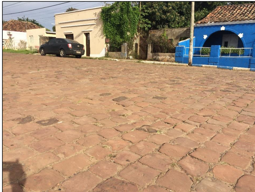
Figura 20 – Revestimento paralelepípedo em estado precário.
