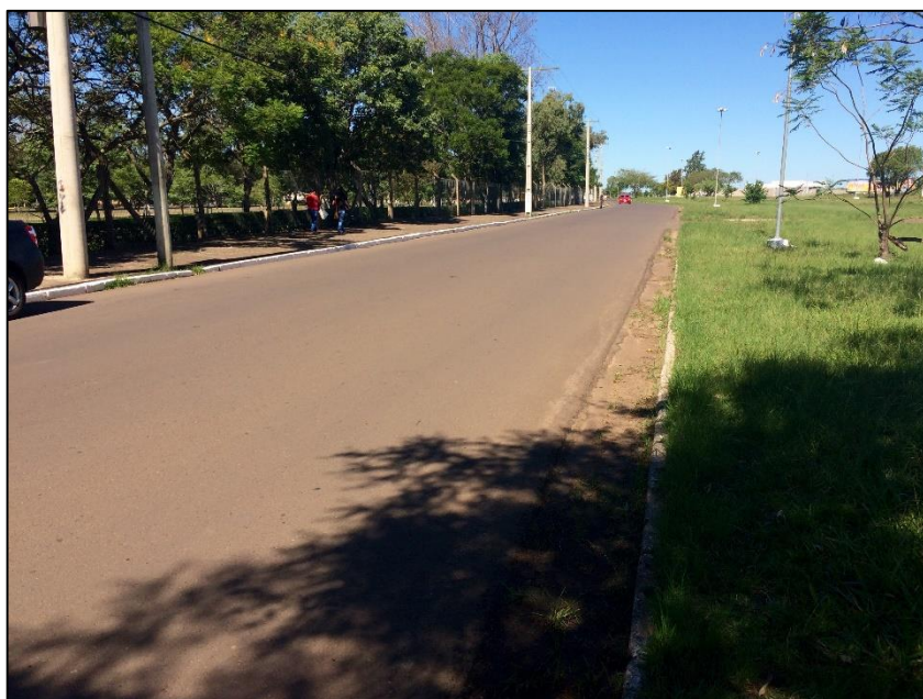
Figura 15 – Revestimento Asfáltico em bom estado
