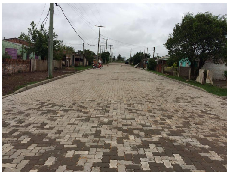
Figura 4 - Pavimento de blocos intertravados de concreto
