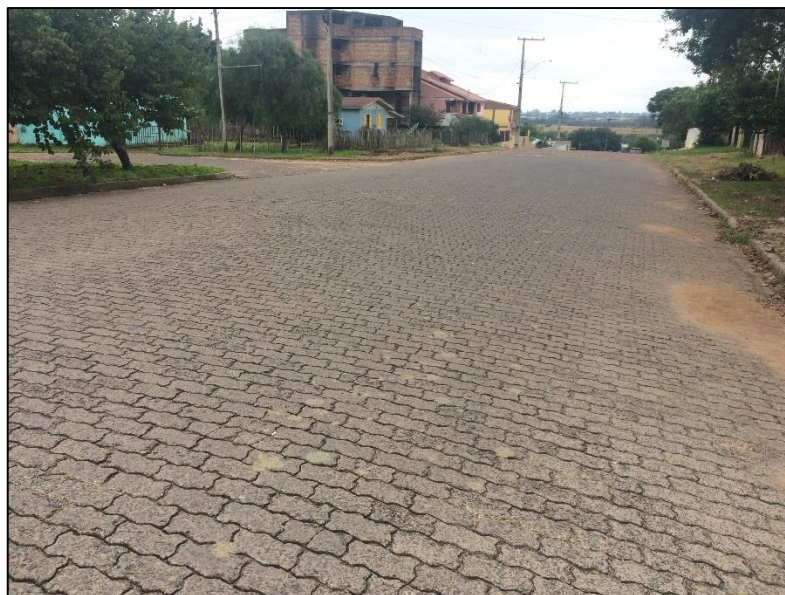
Figura 25 – Revestimento bloco de concreto intertravado já desgastado
