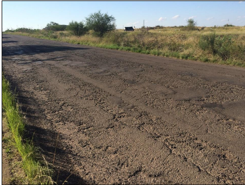
Figura 17 – Revestimento Asfáltico em condições precárias
