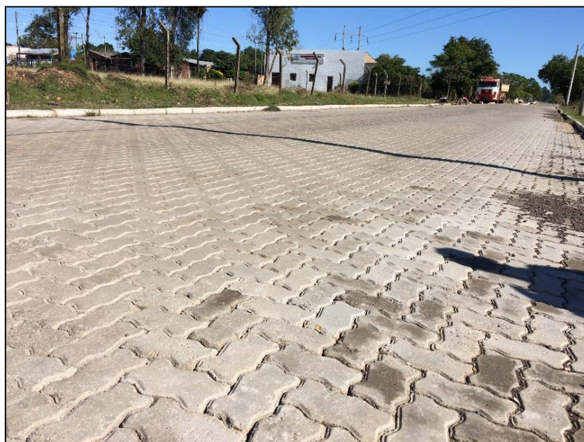
Figura 22 – Revestimento bloco de concreto intertravados em boas condições
