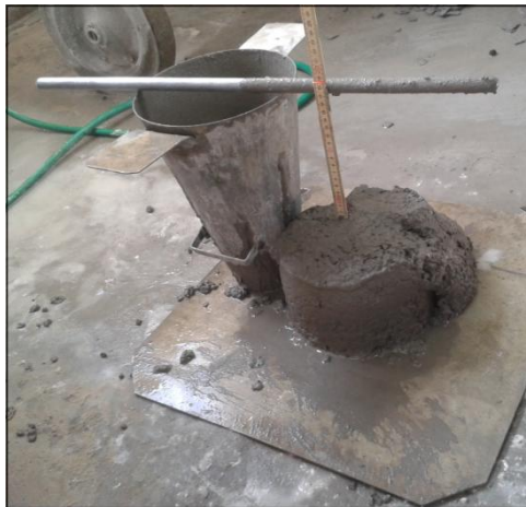
Figura 17 – Terceira concretagem, abatimento 180 mm
