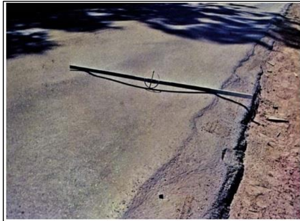
Figura 11 - Afundamento da Trilha de Roda
