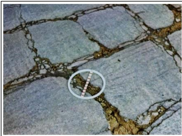
Figura 9 - Trinca interligada “Bloco”
