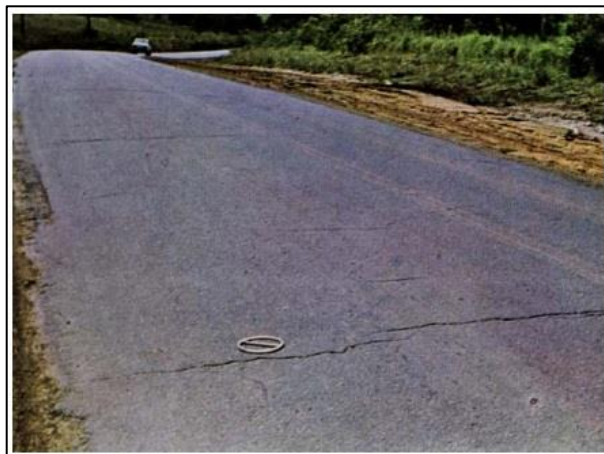
Figura 6 - Trinca isolada transversal
