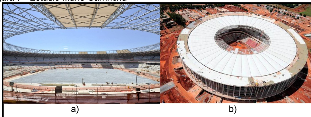
Figura 7 - Estádio Mané Garrincha
