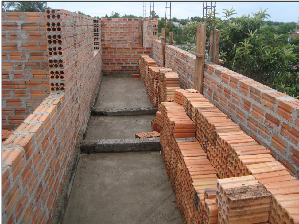
Figura 27 – Tijolos usados na obra e alvenarias na altura de 1,5m
