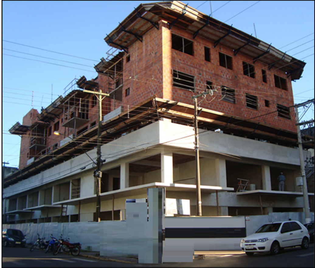
Figura 31 – Fachada da obra em alvenaria estrutural
