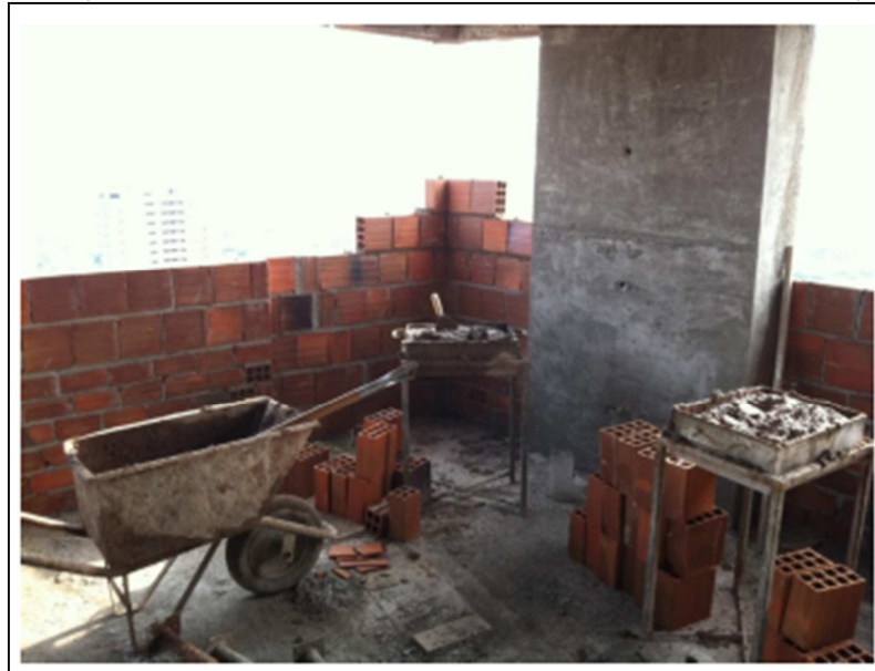
Figura 12 – Disposição dos materiais e equipamentos antes do serviço de alvenaria
