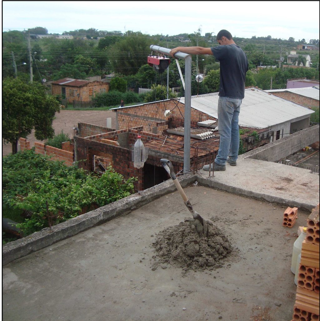
Figura 28 – Guincho utilizado na obra
