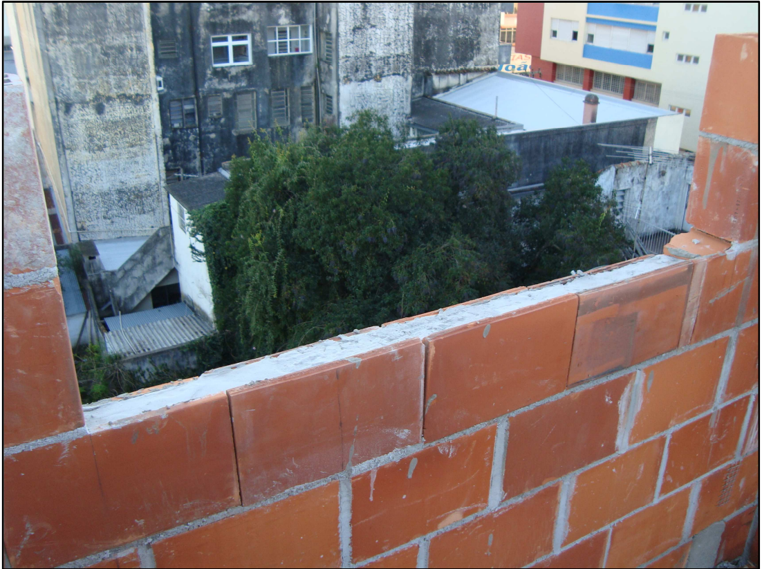
Figura 34 – Verga executada na obra
