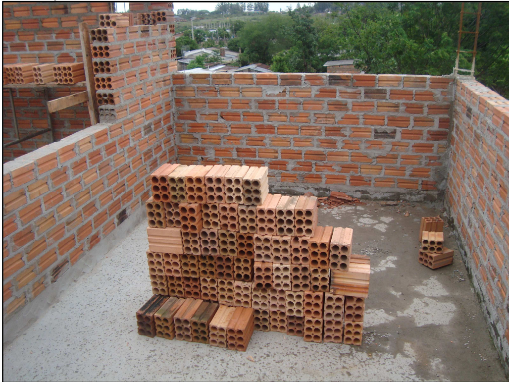
Figura 26 – Tijolos usados na obra
