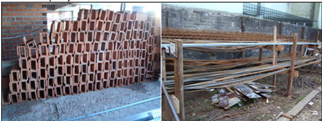
Figura 35 – Disposição dos materiais no canteiro
