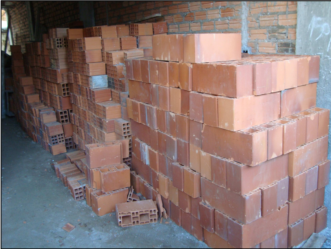
Figura 33 – Blocos cerâmicos utilizados na obra
