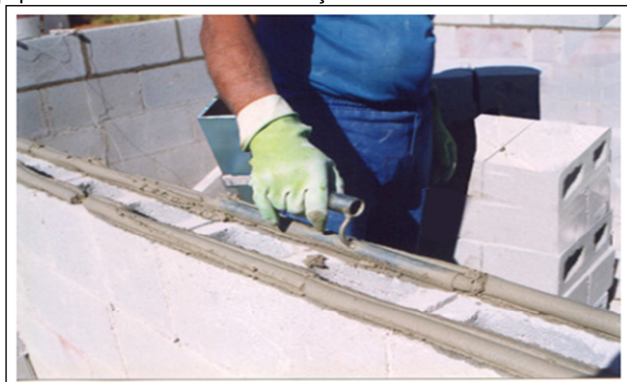
Figura 10 – Equipamentos utilizados na execução de alvenaria
