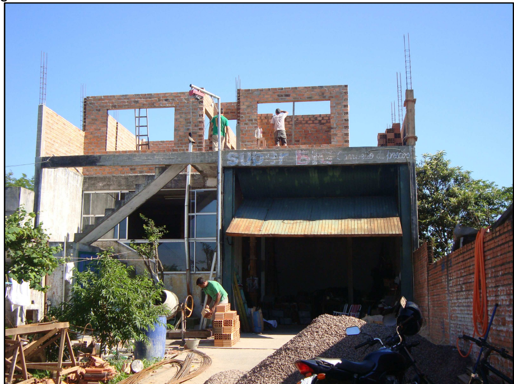
Figura 29 – Canteiro de obras
