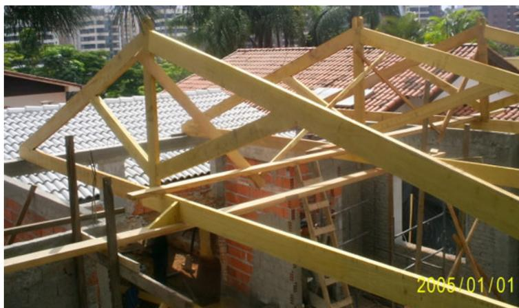
Figura 27: Exemplo de tesoura inclinada em madeira
