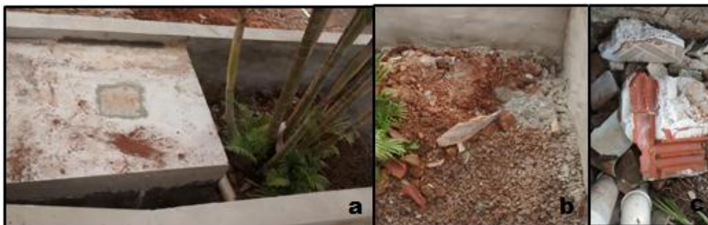
Figura 23 - Reutilização de resíduo em preenchimento ao redor do tanque séptico.
