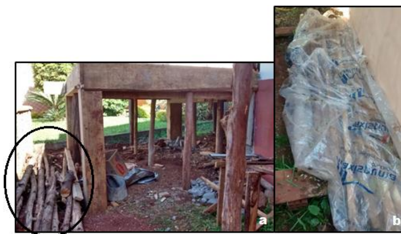
(a) Madeiras desprotegidas e expostas. (b) Realocação e proteção das madeiras com manta plástica. FONTE: autora (2016).
