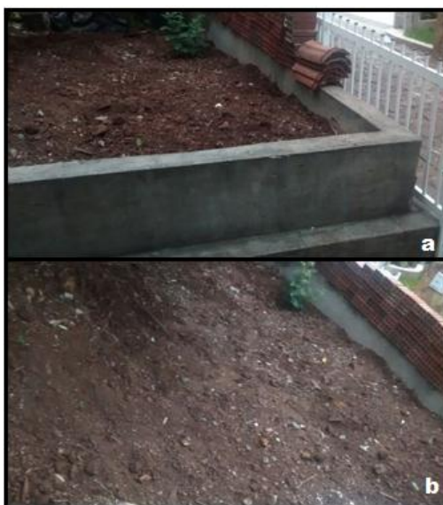
Figura 22 - Reutilização de resíduo em preenchimento para regularização de nível com resíduos classe A.
