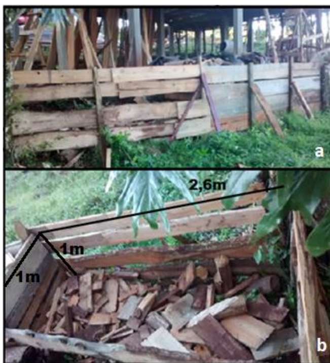
(a) Vista frontal das baias construídas no canteiro de obras da construção nova (b) Aumento de 2,6 m 3 da baia de resíduos da classe B.
