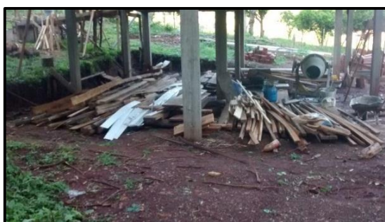
Figura 15 - Materiais dispostos abaixo da construção na obra de construção nova.
