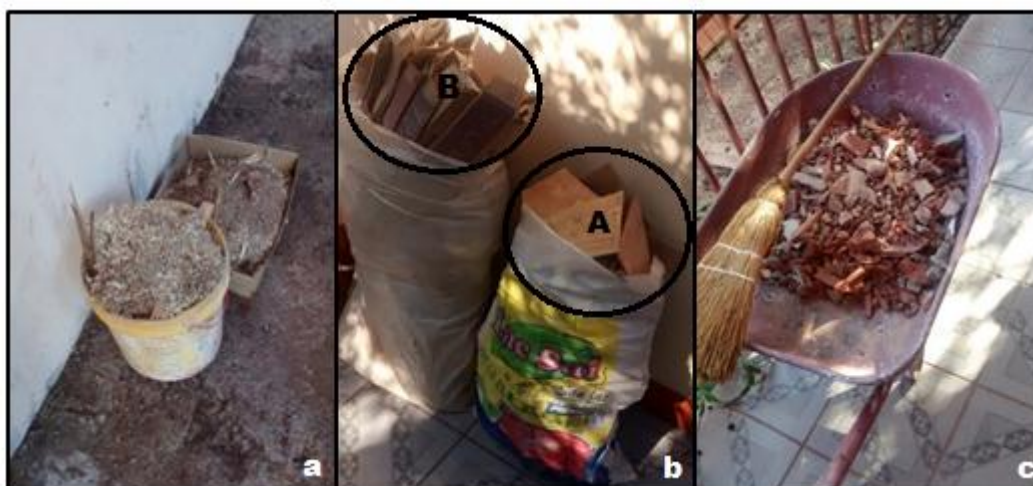
Figura 21 - Segregação de resíduos na obra de reforma.
