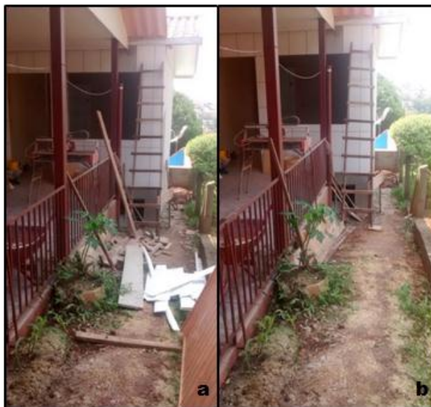
(a) Obra de reforma antes da capacitação. (b) Obra de reforma depois da capacitação. FONTE: autora (2016).
