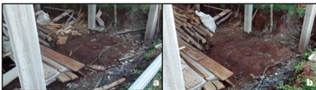
Figura 17 - Antes e depois da capacitação em uma área da obra de construção nova.
