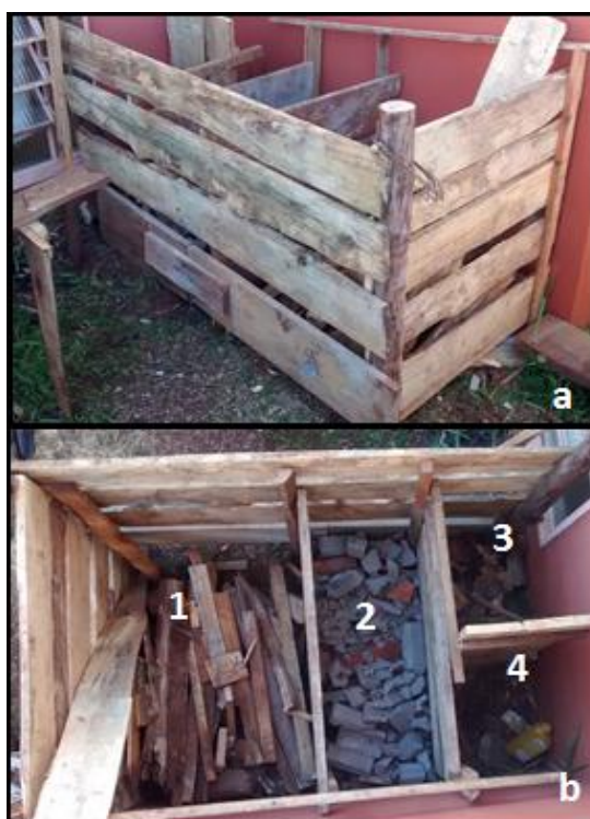
(a) Baias construídas para o acondicionamento de RCC na obra de reforma (b) Acondicionamento de RCC em 1- Classe B, 2- Classe A, 3- Rejeitos e 4- Tóxicos FONTE: autora (2016).
