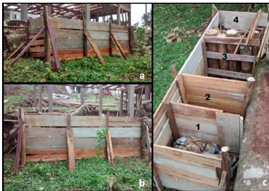
Figura 6 - Baias construídas na obra de construção nova para acondicionamento de RCC.
