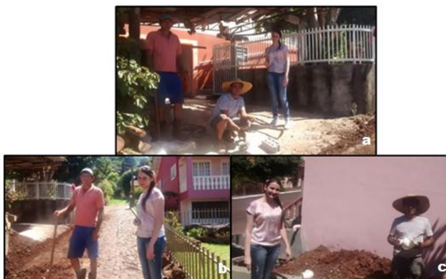
Figura 10 - Capacitação realizada com a equipe de trabalhadores na obra de reforma.
