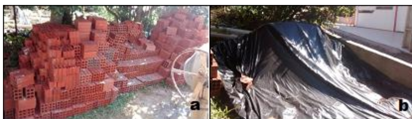
Figura 14 - Tijolos e areia na obra de reforma.
