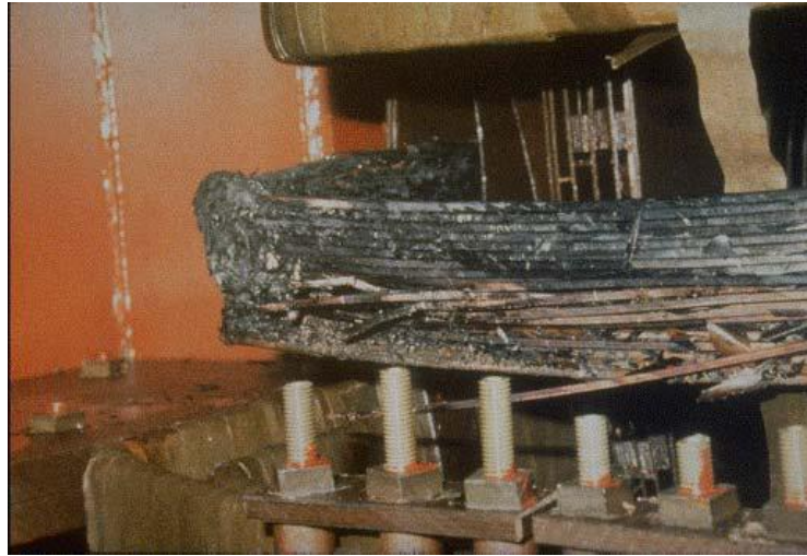
Figura 10 - Transformador com o núcleo danificado.
